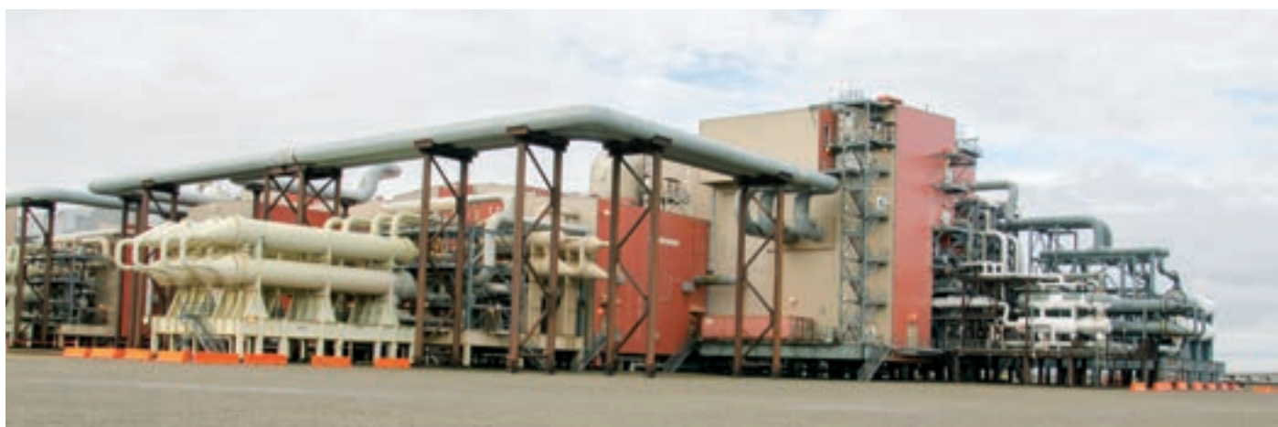
ГПЗ Prudhoe Bay Unit Central Gas Facility на Аляске
