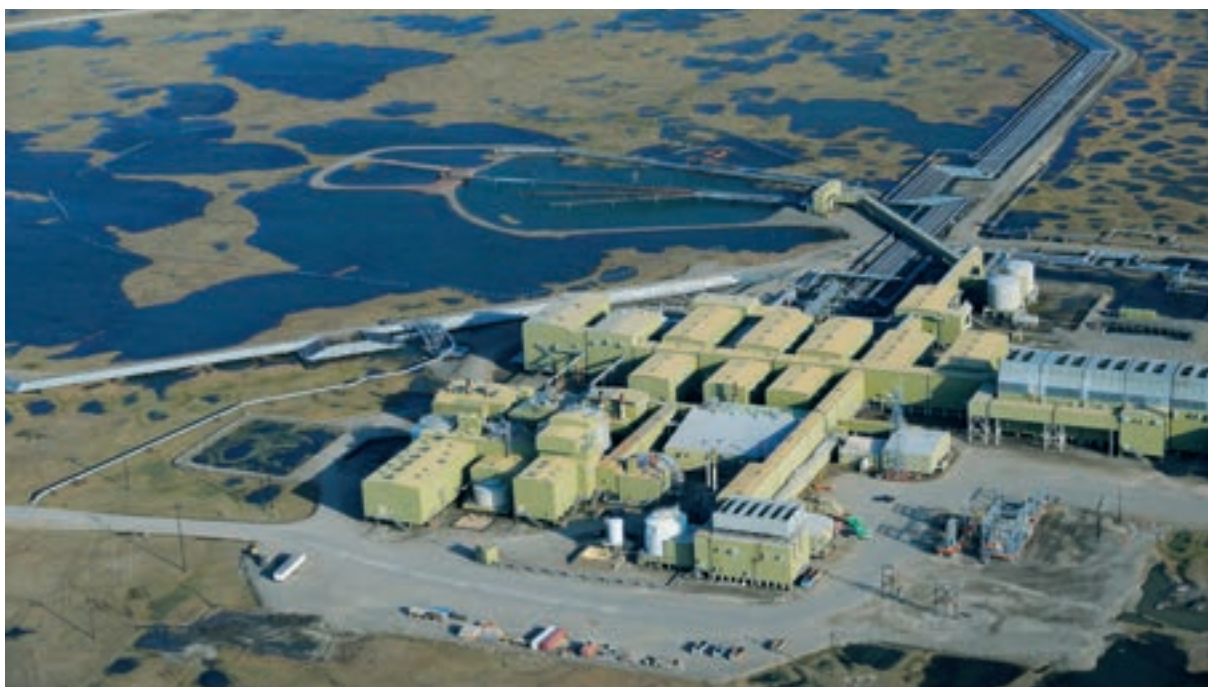
ГПЗ Prudhoe Bay Unit Central Gas Facility на Аляске
