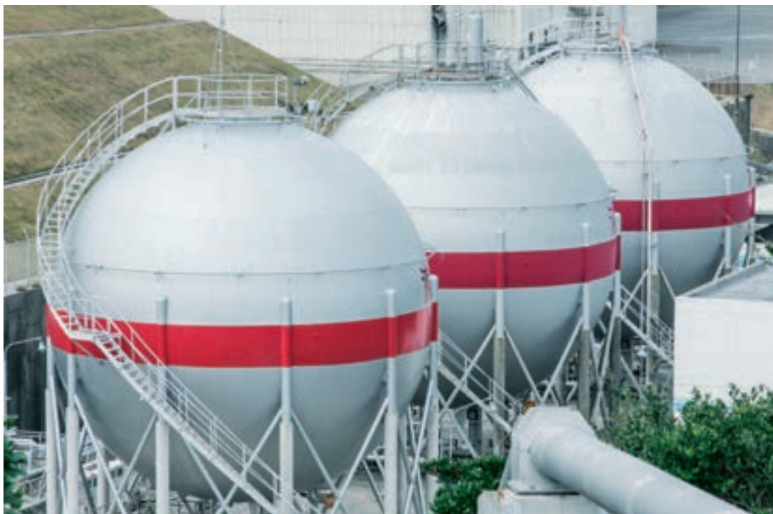
Резервуары для хранения сжиженного водорода в Космическом центре Танегасима, Япония
