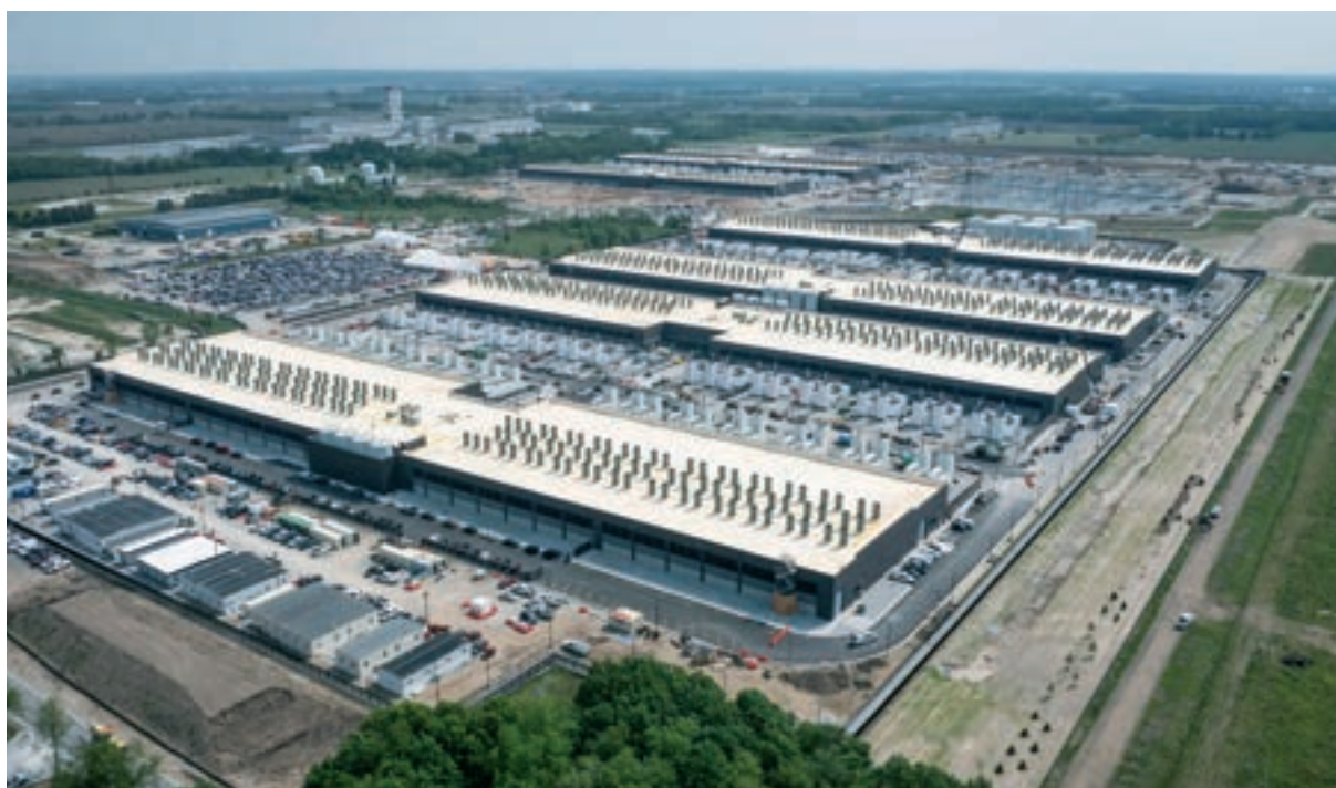
Дата-центр Amazon в Индиане
