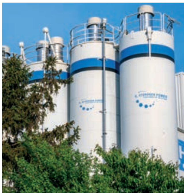
Резервуары для хранения водорода Источник: Shutterstock.com
