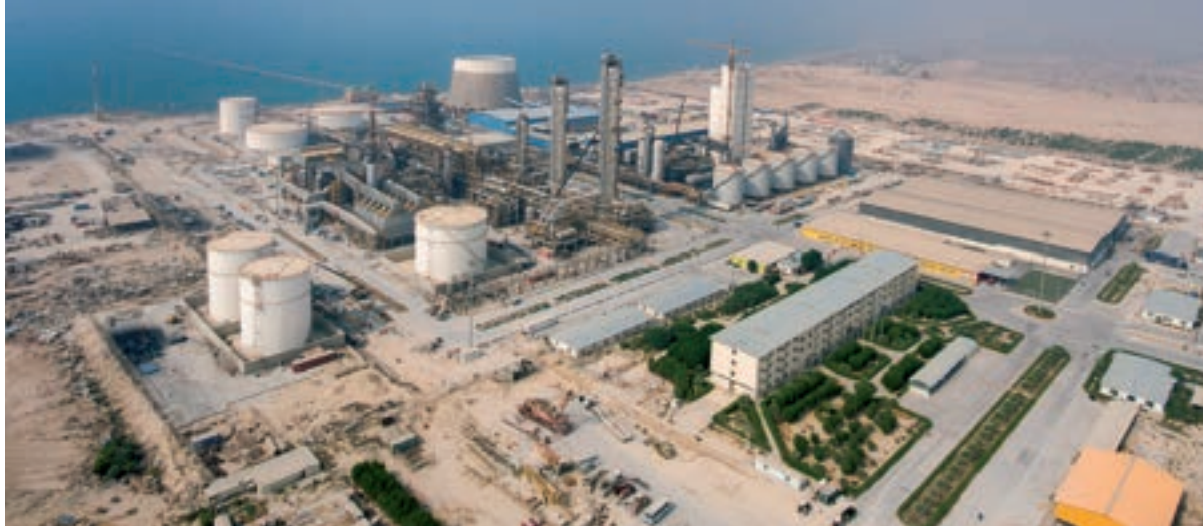
Завод Kaveh Dayer Methanol Plant в Иране
