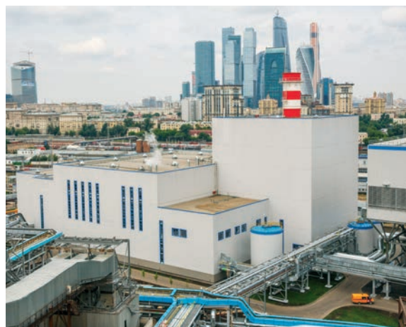
Энергоблок ПГУ-220 ТЭЦ-12 ПАО «Мосэнерго»
