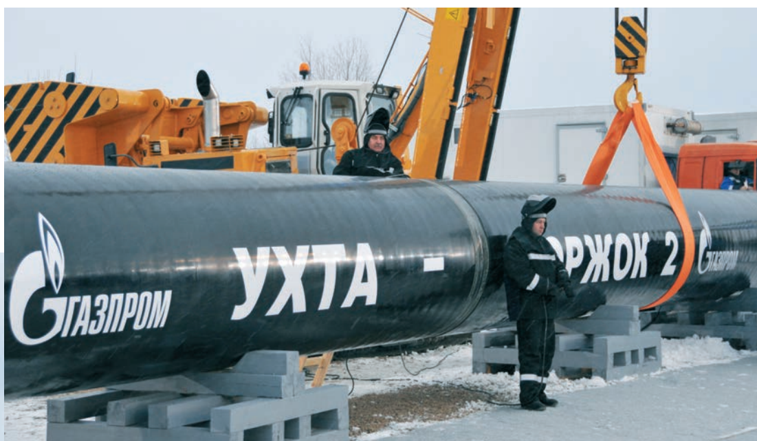
Газопровод Ухта – Торжок 2
