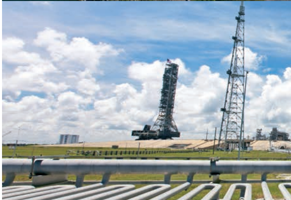
Хранилище жидкого водорода
