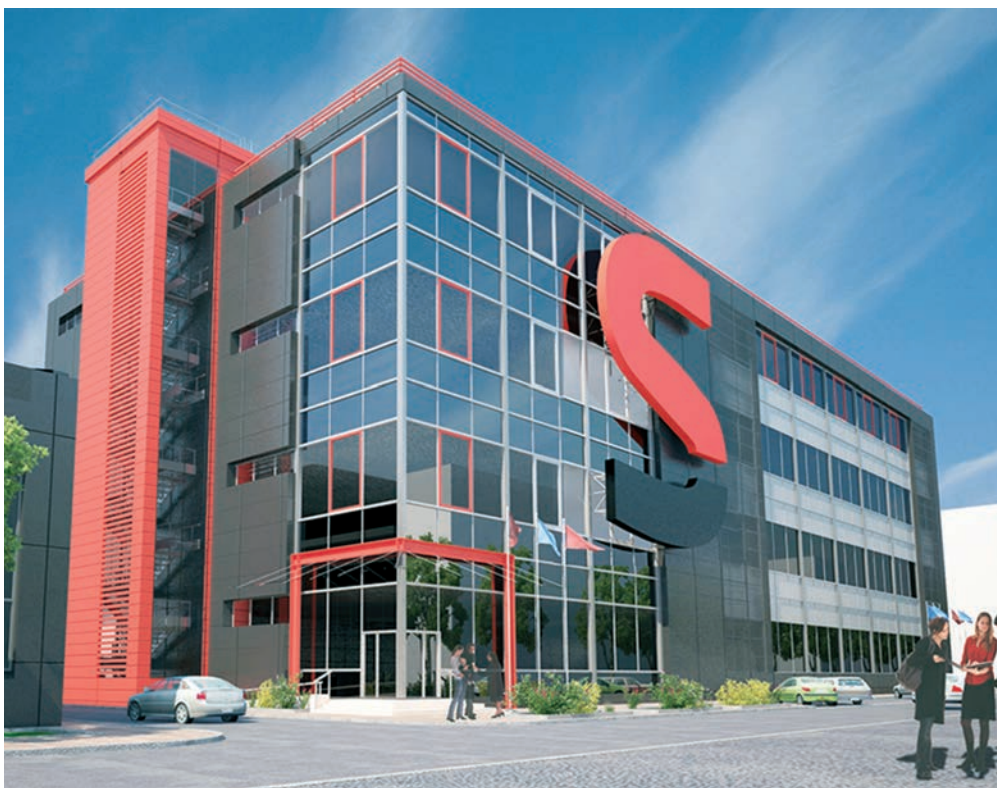
ЦОД компании Selectel в Санкт-Петербурге
