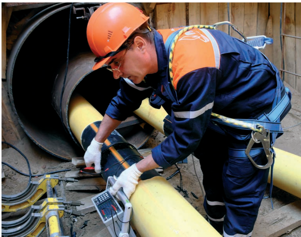
Укладка межпоселкового газопровода
