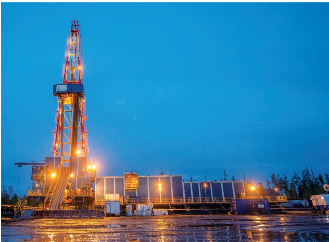
Бурение скважины, ИНК
