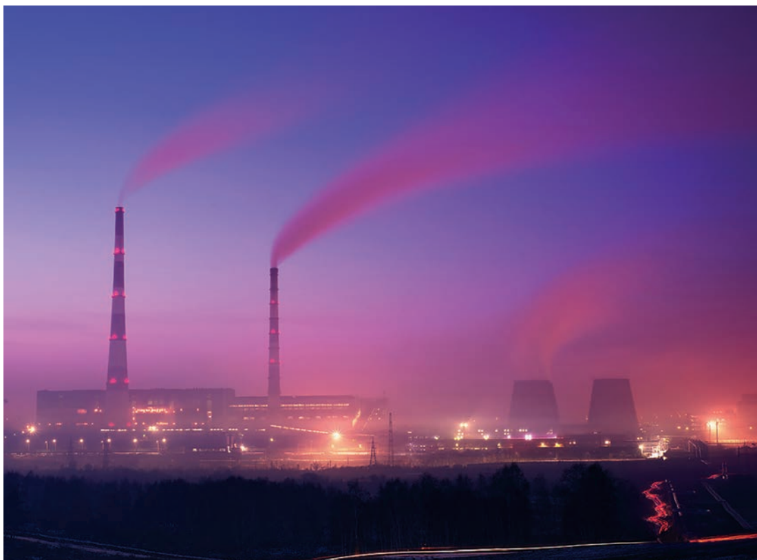
Ново-Иркутская ТЭЦ, Иркутская область
