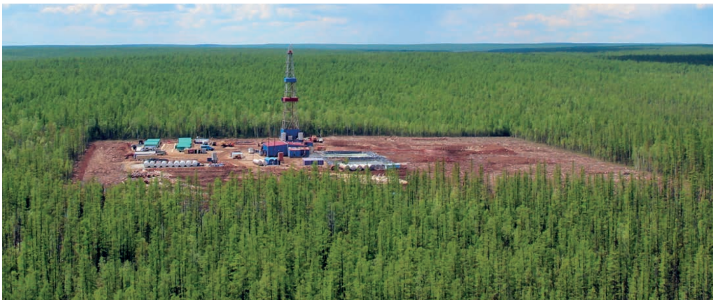
Бурение скважин на Ковыктинском месторождении
