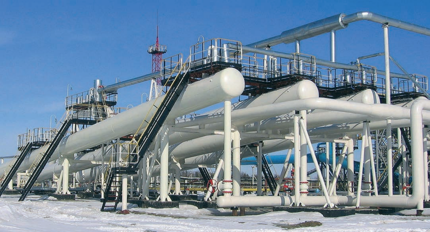
Установка предварительного сброса воды
