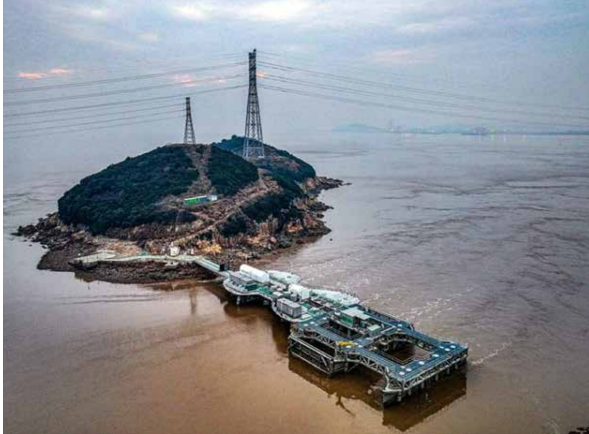
Приливная электростанция Zhoushan, Китай
