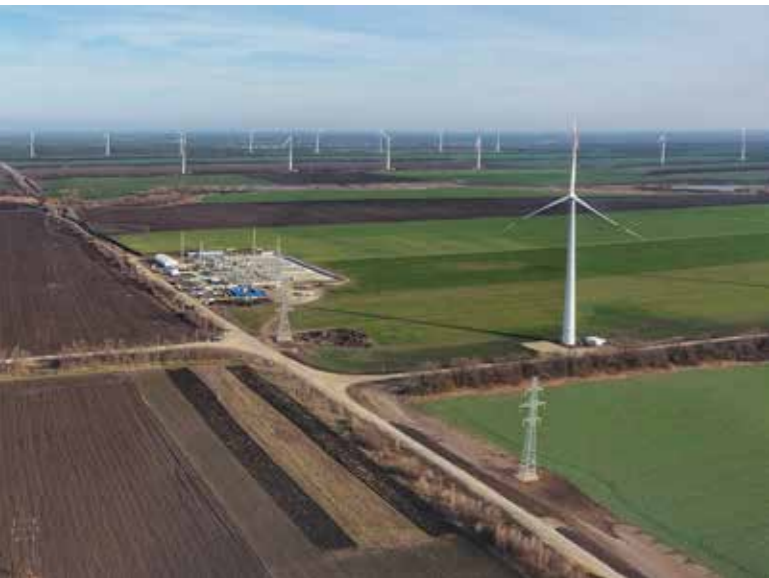
Адыгейская ВЭС Источник: «Новавинд»
