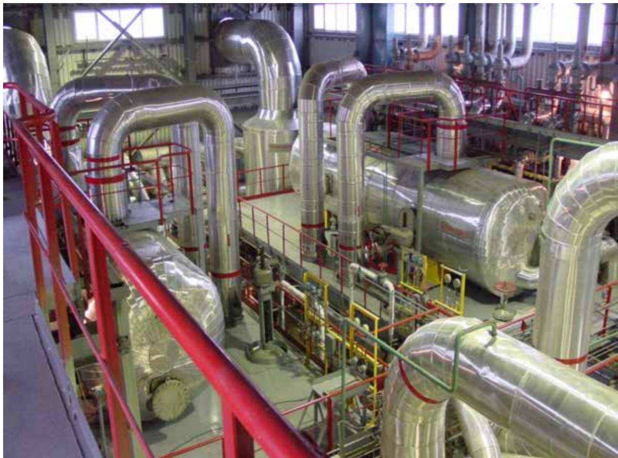
Рис. 2. Гравитационные горизонтальные сепараторы на энергоблоке МГеоЭС-1
