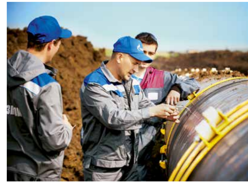
Строительство газопровода Источник: «Газпром»
