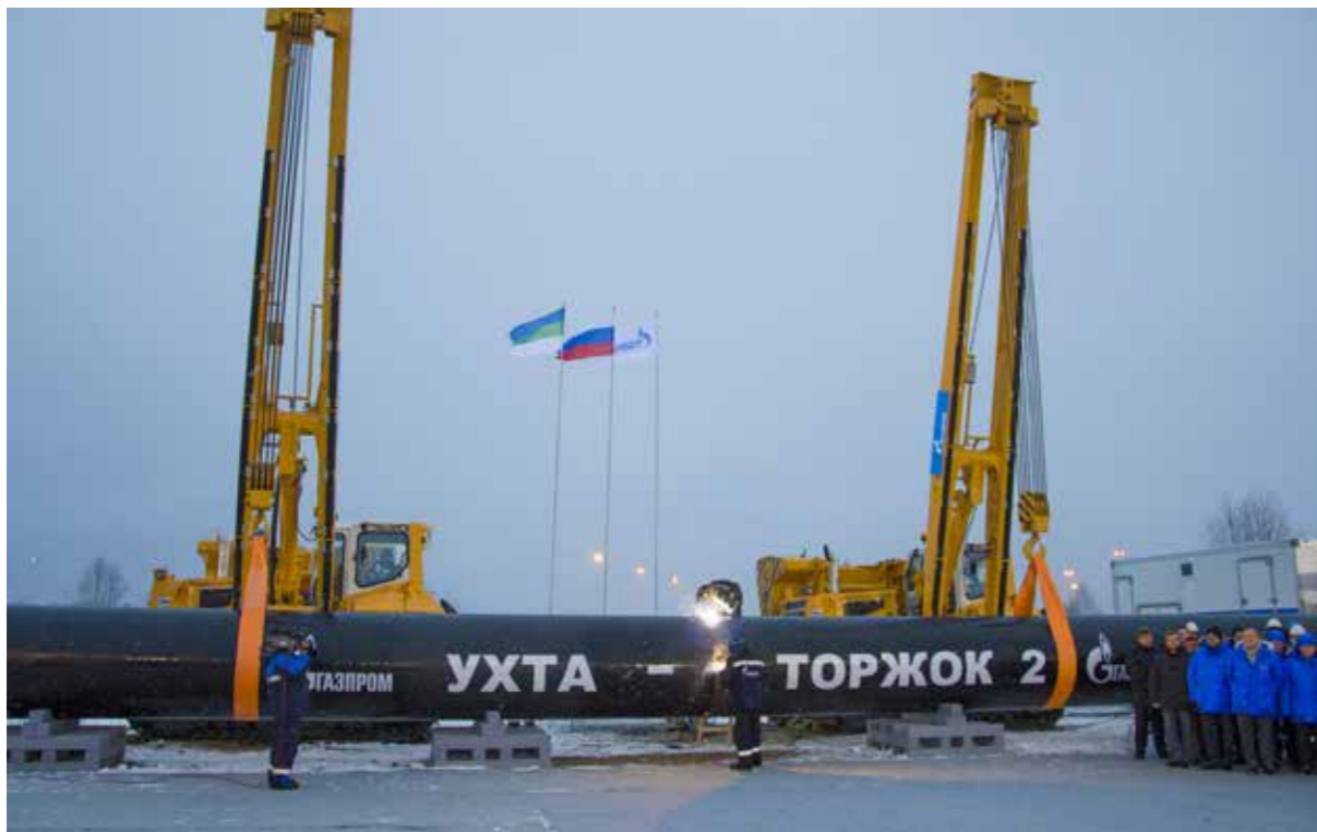
Сварка первого стыка газопровода «Ухта – Торжок-2»
