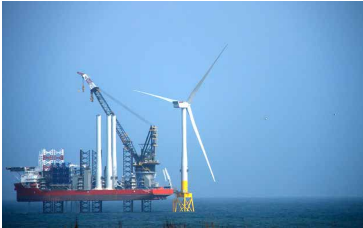
Установка ветряных турбин. Берег Абердина, Шотландия
