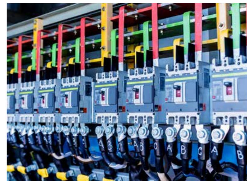
Трансформаторная подстанция Источник: Romaset / depositphotos.com
