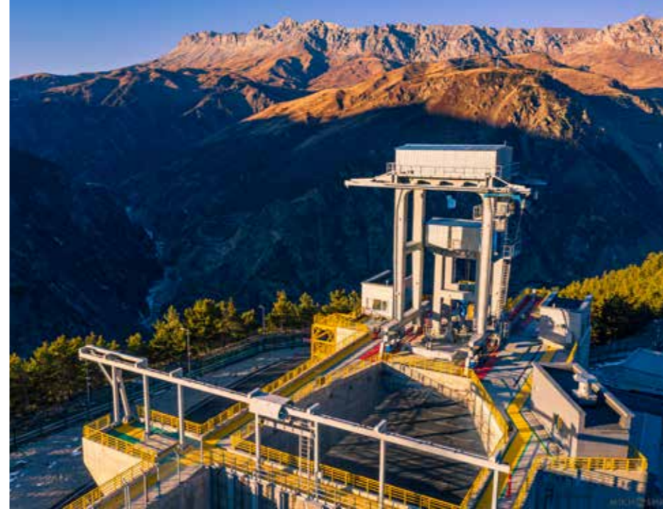
Зарамагская ГЭС-1 Источник: «Русгидро»
