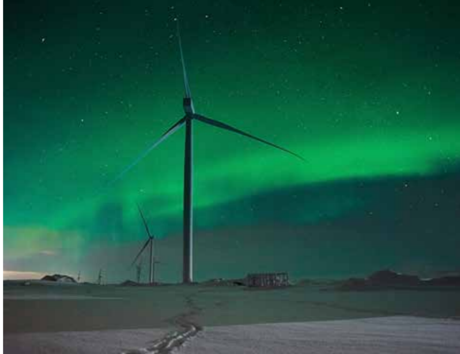
Кольская ВЭС Источник: Enel
