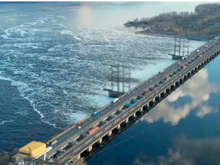
Жигулевская ГЭС Источник: tvsamara.ru
