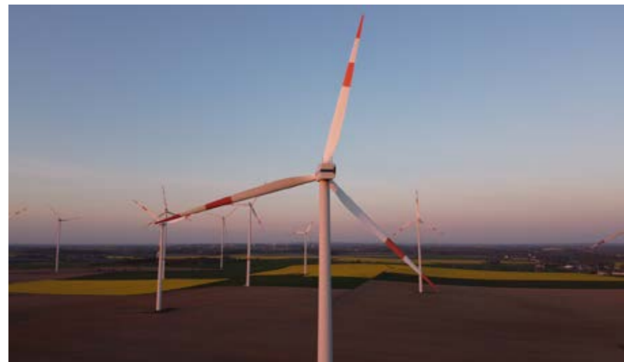
ВЭС, Ставропольский край
